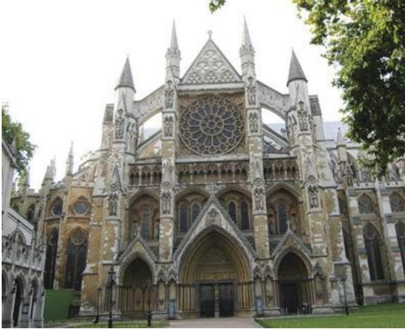
La abadía de Westminster comenzó a construirse en 1245. En la fachada norte se aprecia el gran rosetón central apoyado en los arbotantes que transmiten los empujes a los contrafuertes, así como el triple pórtico restaurado. Foto: Ana Vaquero.
